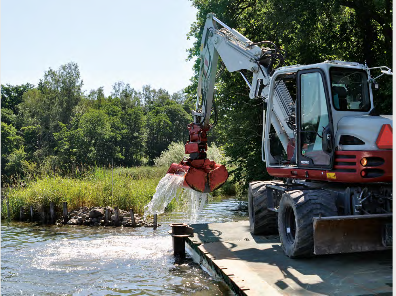
Mündung des Petribachs in den Rhein in Schlatt (Kanton Thurgau) am 24. Juni 2020. Im Mündungsbereich wird ein Pool ausgebaggert, in dem sich das etwas kältere Wasser des Petribachs sammelt. Darin finden Fische Zuflucht, wenn das Rheinwasser im Sommer zu warm wird.
