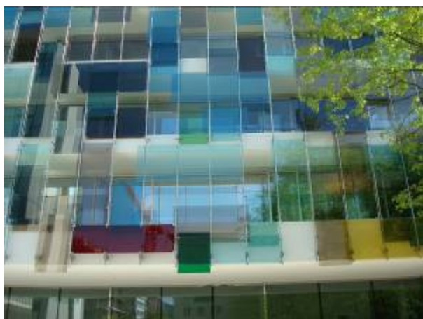
Fig. 10: Facciata di rivestimento in vetro
