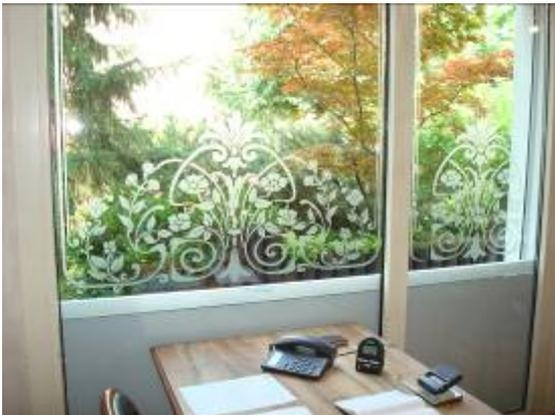
Abb. 7: Bildmuster mit geringem Bedruckungsgrad, keine Sichtbehinderung
