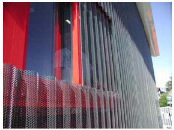
Abb. 16: Verschiebbares Fassadenelement, zulässig
