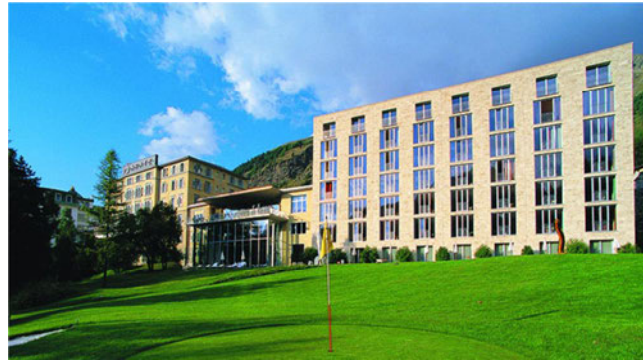
Abb. 22 Hotel Saratz Pontresina nach Investition (Fotografie der realisierten Anlage)
