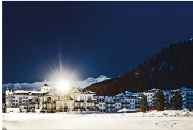
Abb. 34 Kempinski Residences St, Moritz (Fotografie der realisierten Anlage)
