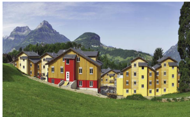
Abb. 25 Landal Feriendorf Morschach (Fotografie der realisierten Anlage)
