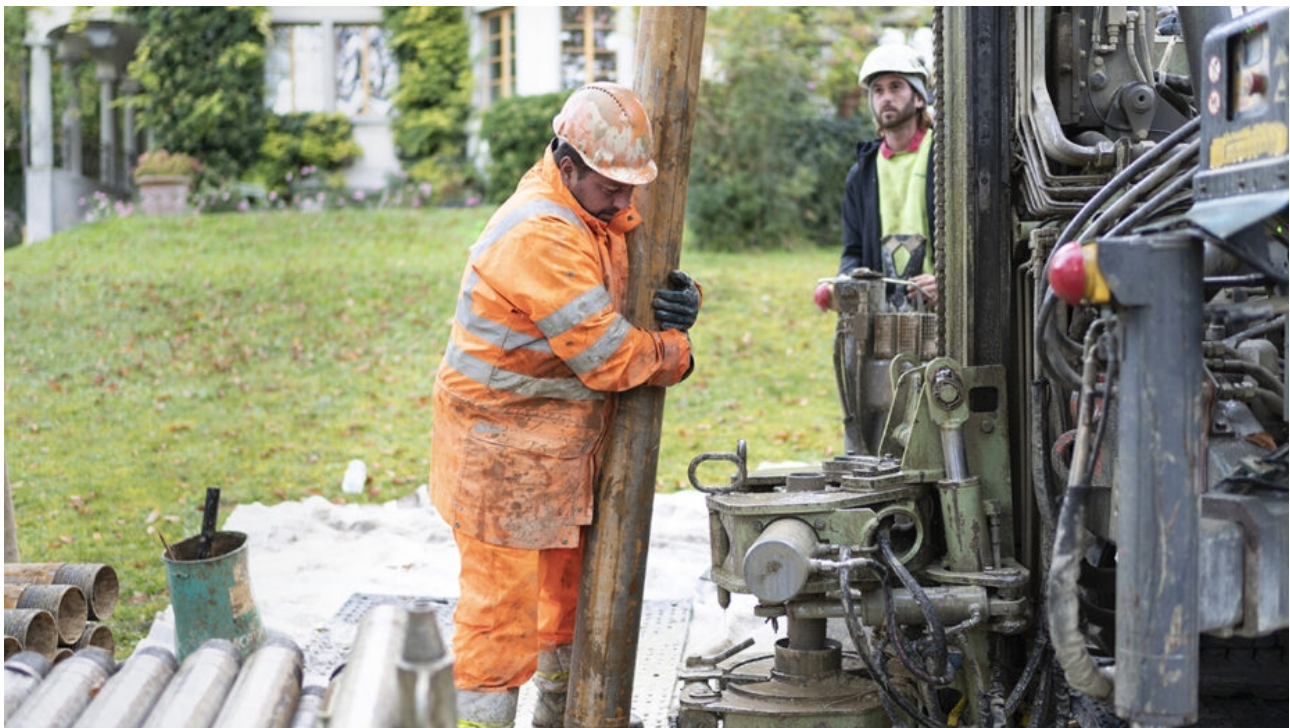
Erneuerbare Energien könnten von der Gesetzesänderung profitieren: Arbeiter installieren eine Erdwärmesonde. (Bild: Keystone)
