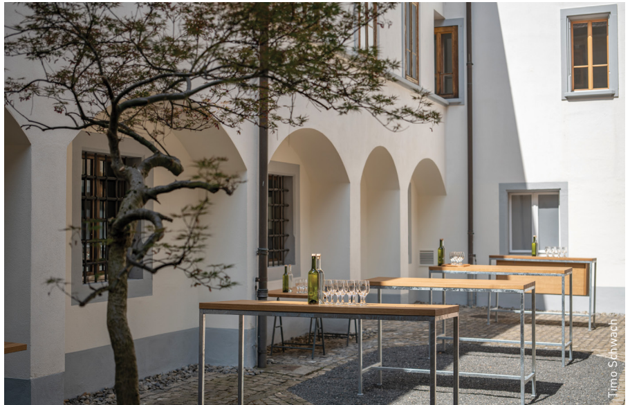
Im August 2020 öffnete die Einrichtung nach einer 18-monatigen Umbauphase ihre Türen.
